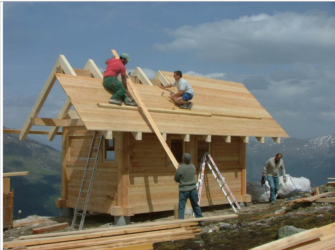
Bild 2: Auf Alp Sadra wird auf 2500m eine neue Hütte gebaut.
